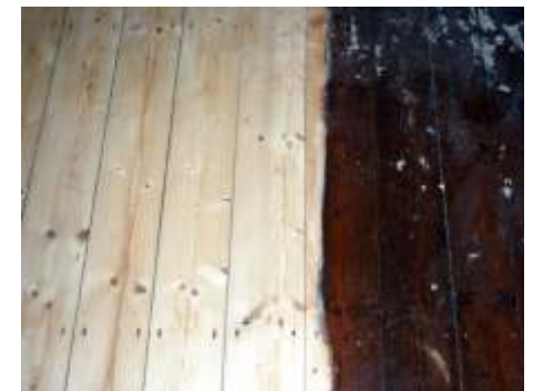
Dielenaufarbeitung (rechts vorher, links nachher)
